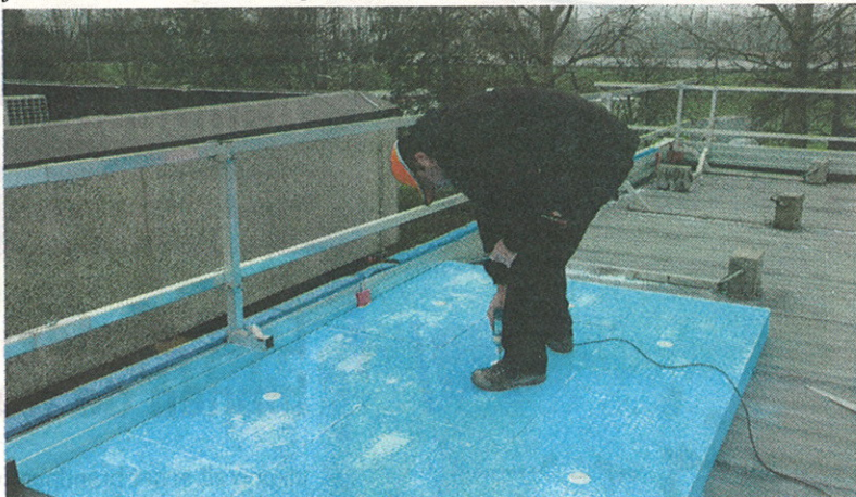
Het vezelvrije materiaal weegt slechts 80 kilo per kubieke meter. Voor een dakdekker betekent het minder sjouwwerk.
